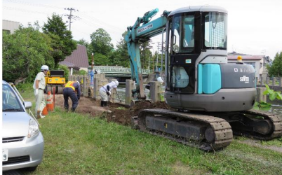
沖館橋～田橋間の掘削工事の様子
